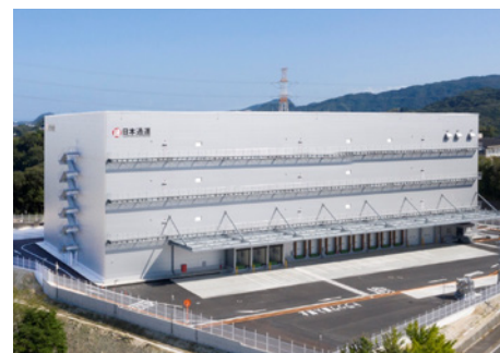
九州医薬品センター
